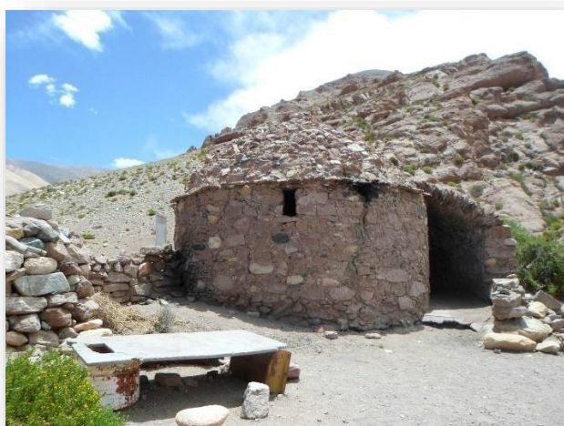
Refugio construido camino a Laguna Brava
